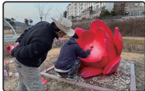
조형물 등 특수 도장 공사
