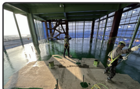
옥상, 주차장바닥 방수 및 에폭시 공사
