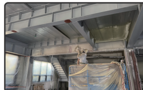
우레탄 단열공사 내화, 흡음 뽐칠 공사
