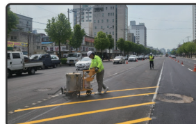
주차장, 도로, 공원 차선 도색공사
